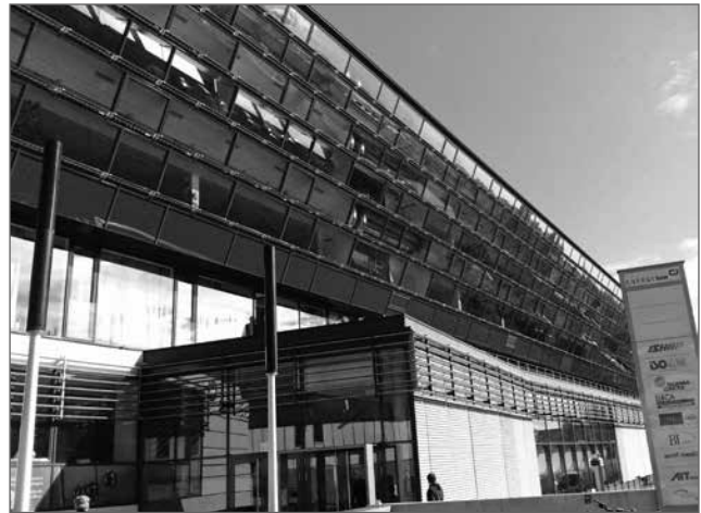
Abb. 6: Projektpartnergebäude E-Office Energie Steiermark Graz
